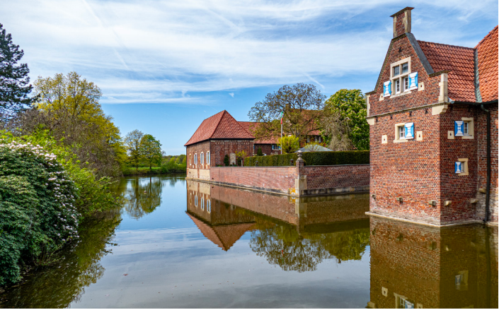
Haus Borg, Blick über die Gräfte auf der Westseite
